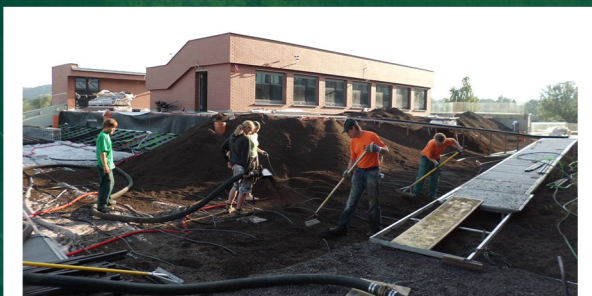
Foukání substrátu na střechu - Bratislava
